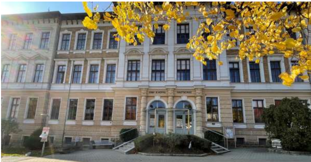
Abbildung 93 Schulgebäude (Foto von Schulwebsite, 2025, http://www.schoeffelschule.at/ )
